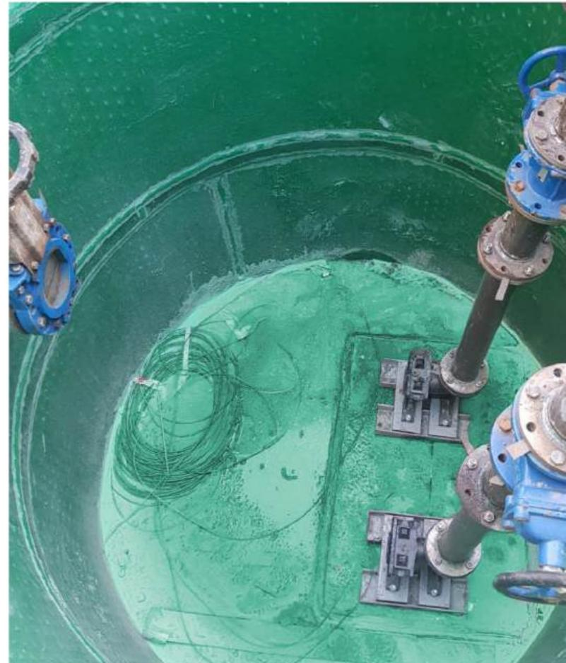
Применение анкерного листа с V-образными элементами обеспечивает прочность на отрыв не менее 20 кН/м при восприятии гидростатического давления, что позволяет строить сооружения на глубине до 15 м.
