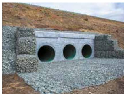
Рис. 3. Водопропускное сооружение после ремонта по технологии «ПайпАрм»
